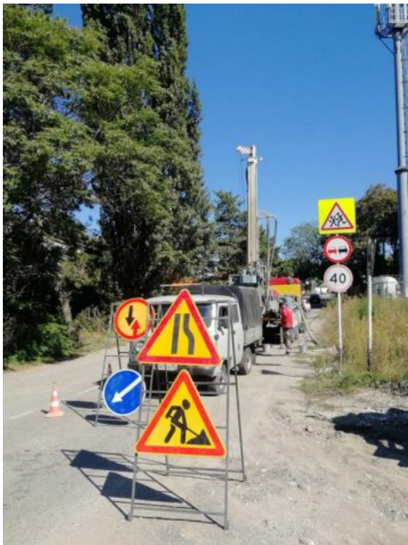
Фото 9. Процесс бурения С-5, буровой установкой УРБ-51, по ул. Этокской в ст. Ессентукской
