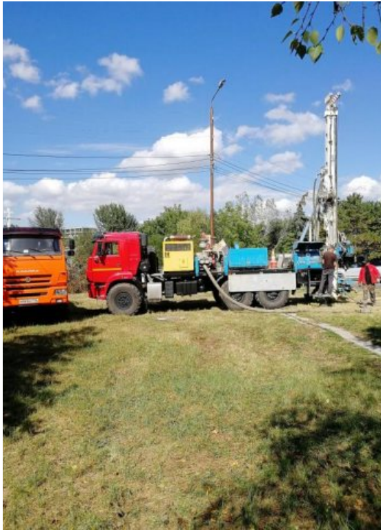
Фото 13. Процесс бурения С-6, буровой установкой УРБ-51
