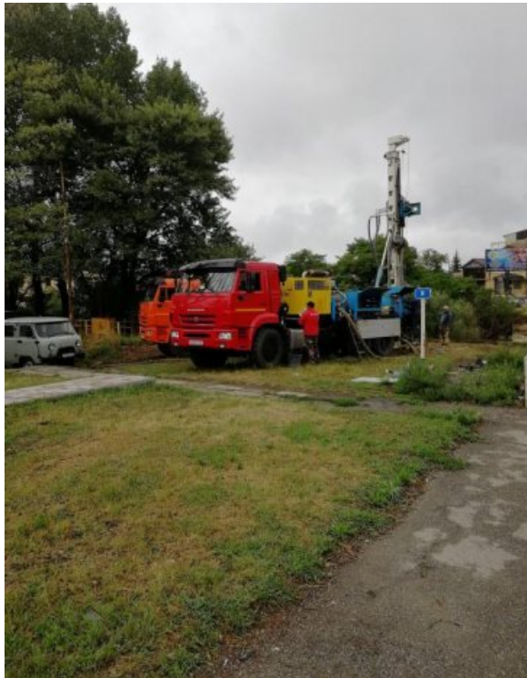
Фото 1. Процесс бурения С-1, буровой установкой УРБ-51
