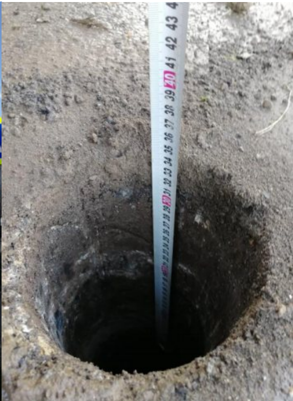
Фото 18. Замер мощности асфальтобетона в С-8, по ул. Гаевского в г. Ессентуки
