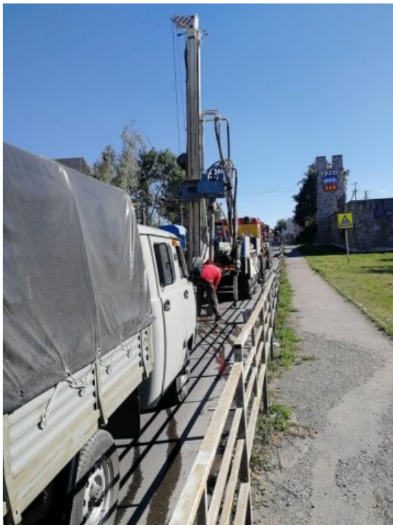
Фото 15. Процесс бурения С-7, буровой установкой УРБ-51, по ул. Шести Коммунаров в ст. Ессентукской
