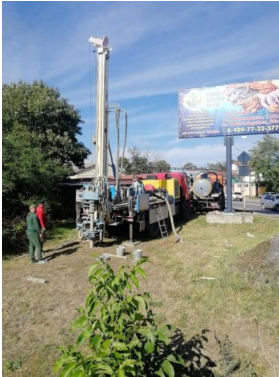
Фото 5. Процесс бурения С-2, буровой установкой УРБ-51
