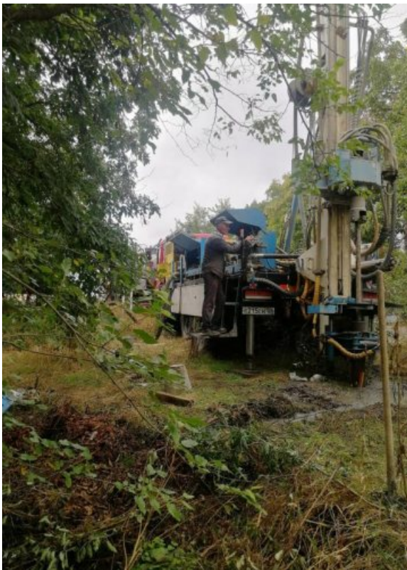
Фото 7. Процесс бурения С-4, буровой установкой УРБ-51
