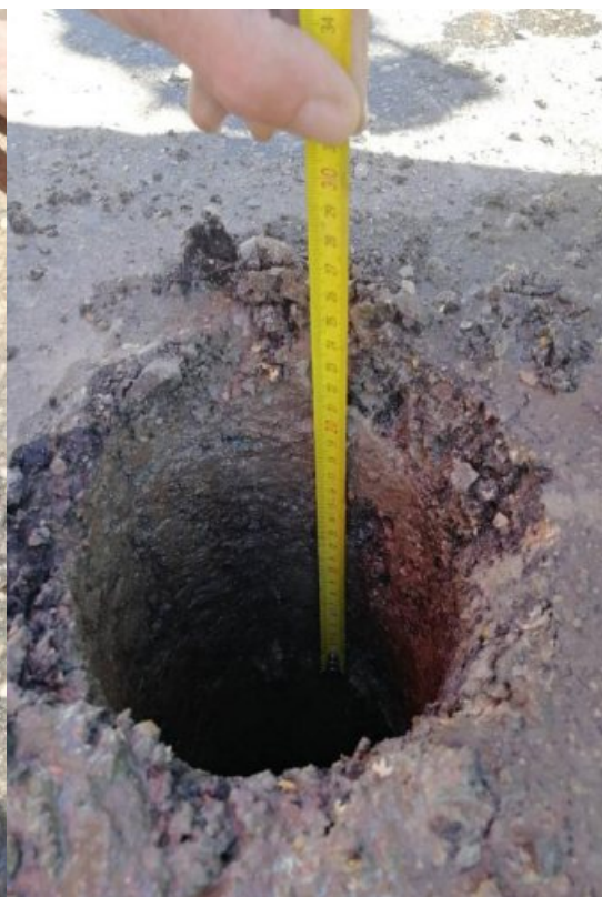
Фото 12. Замер мощности асфальтобетона в С-7, по ул. Шести Коммунаров в ст. Ессентукской
