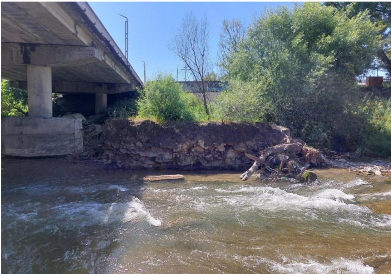
Рисунок К.4 — Река Подкумок В районе створа ПП2, на переднем плане опора старого моста
