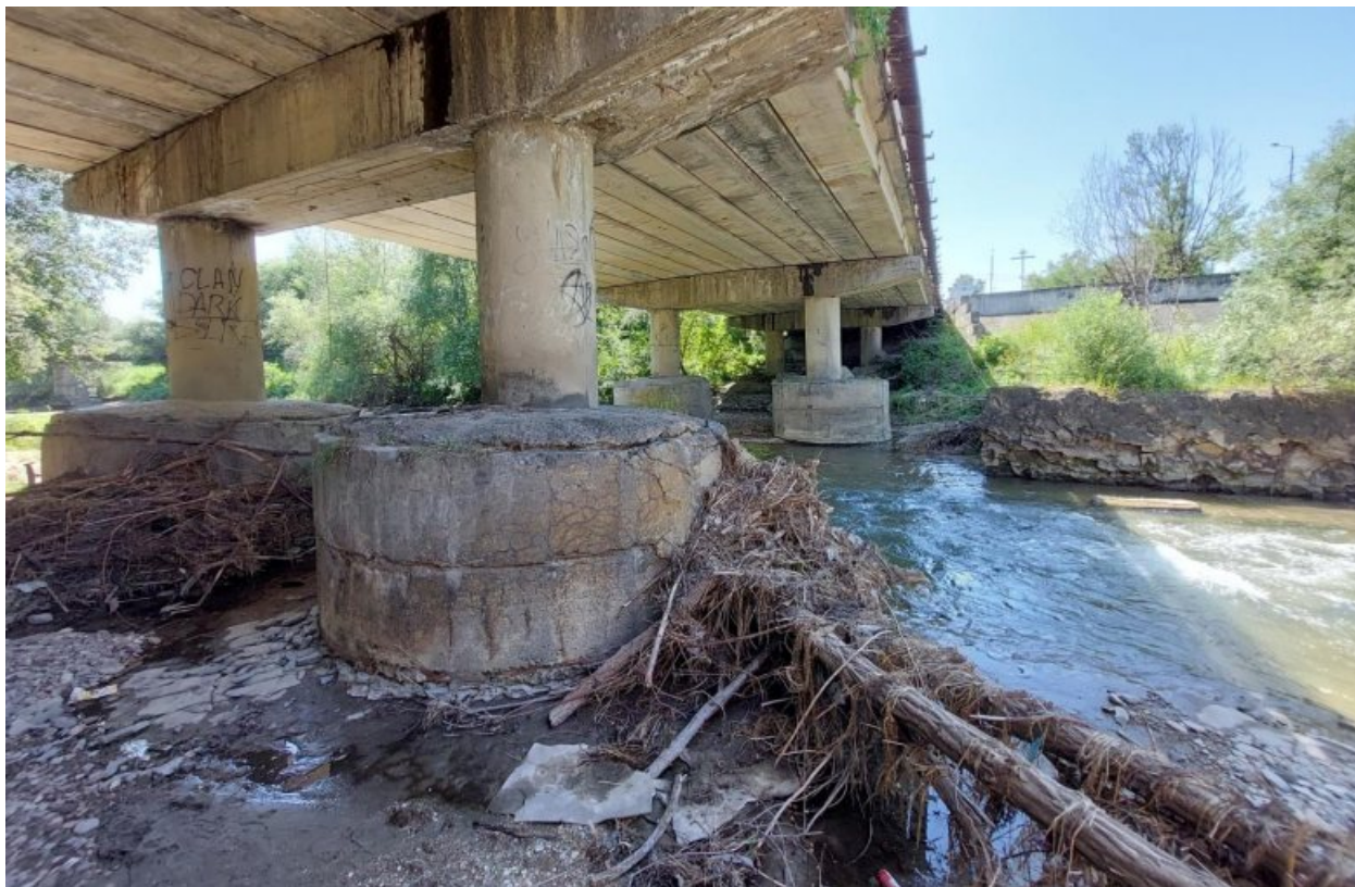
Рисунок К.5 — Карчевый материал у опор моста
