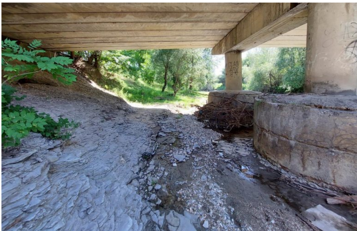
Рисунок К.6 — Левый берег подмостового сечения, практически полное отсутствие аллювиального материала
