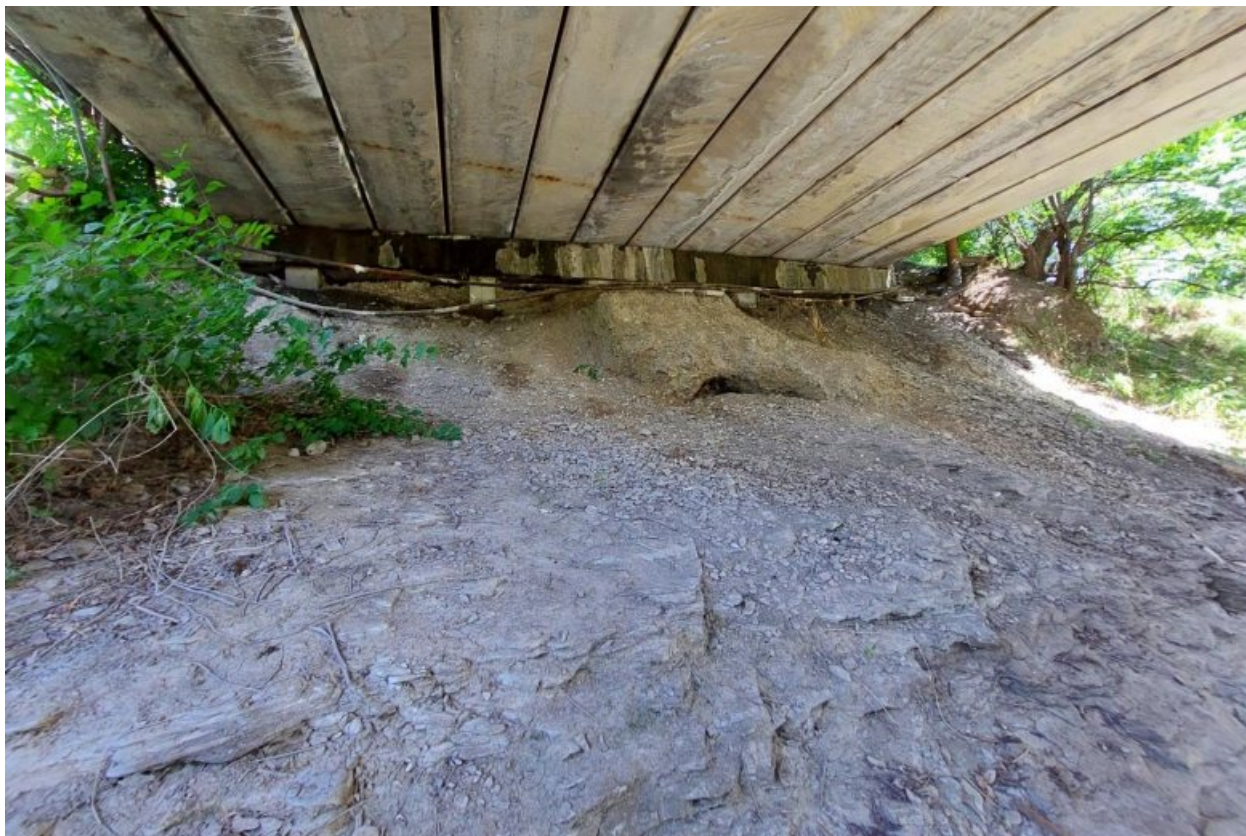
Рисунок К.7 — Выходы коренных мергелей в подмостовом сечении
