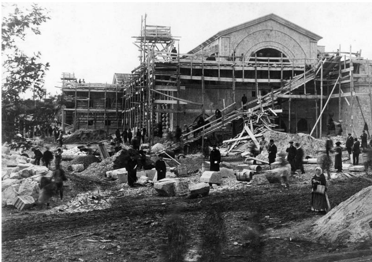
Рисунок 2.4.9. Строительство грязелечебницы. 1915 г. 22
